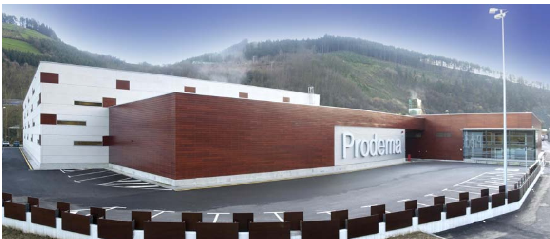
Fig. 1 Instalaciones de PRODEMA, S.A. en Legorreta (Guipuzcoa). Fuente: PRODEMA S.A.
