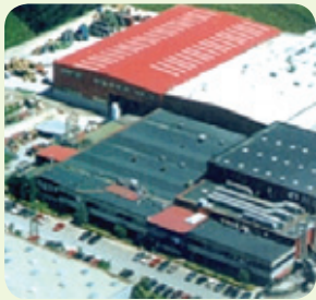
▲ Vista panorámica de las instalaciones.
