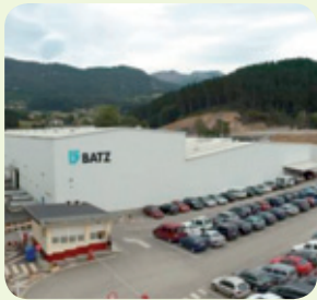
▲ Fot. 1. Vista panorámica de las instalaciones centrales en Igorre (año 2008).
