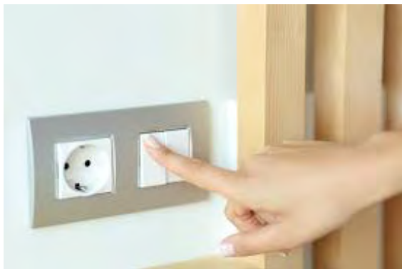
Hormarekin kontrastatutako etengailu eta korrante-hargunearen adibidea
