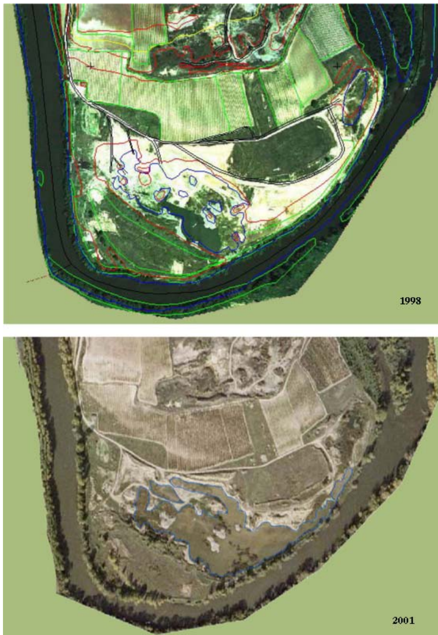
Figura 2. Gimileo es un humedal de reciente construcción que ha sufrido importantes cambios en tiempos recientes. En 1998 (ortofotografía superior), Gimileo estaba formado por dos lagunas independientes, que no presentaban ninguna conexión superficial con el río Ebro. En 2001 se aprecia un incremento de la superficie del humedal, quedando constituido por una cubeta principal de forma sinuosa y dos cubetas menores que eventualmente se comunican en periodos en los que se produce una elevación del nivel del agua (en la imagen únicamente se observa solo una de las cubetas aisladas); Además de estos cambios morfológicos el humedal presenta una conexión directa con el río Ebro en su orilla este que no existía antes de 1998. La línea azul delimita aproximadamente la superficie ocupada por la lámina de agua en ambos periodos.
