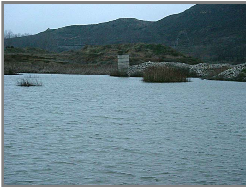
Figura 25. La retirada de antiguas infraestructuras, como la que puede verse en la imagen, representaría una indudable mejora paisajística del entorno.
