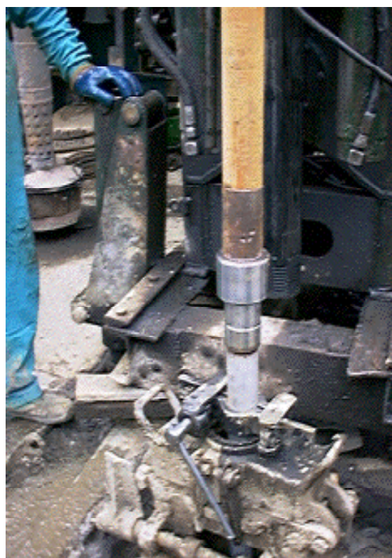
Entubación a Ø 2". Reducción N (rosca a izquierdas)-2"
