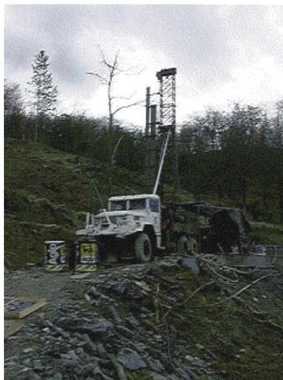
Perforando sondeo T-4
