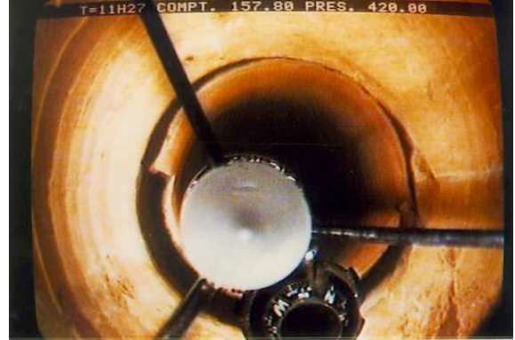
Foto 9 (157,8 m). Parte superior de la tubería de revestimiento de ø516x500mm.
