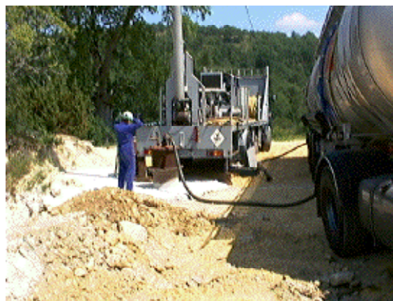
Labores de inyección
