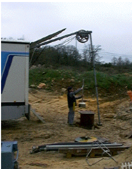
Registro de flujo. Micromolinete con campana reductora
