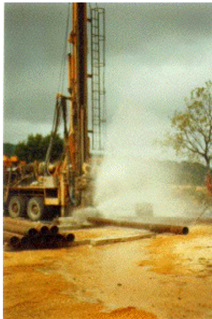
Labores de "air-lift"
