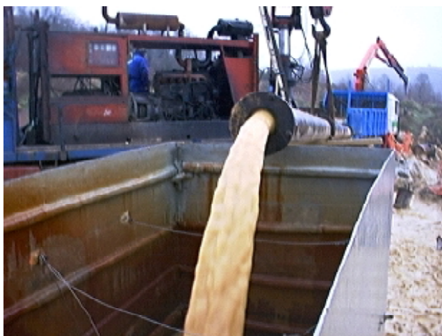
Bombeo Zikujano-B. Q_b=19 \text{ l/s}
