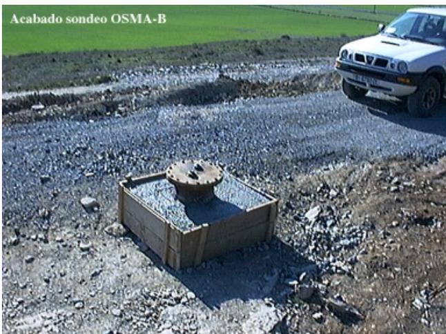
En resumen, se cierran los 30 primeros metros con tubería de Ø400 mm y se cementa el espacio anular. El resto del sondeo hasta los 250 m queda abierto (open-hole).
