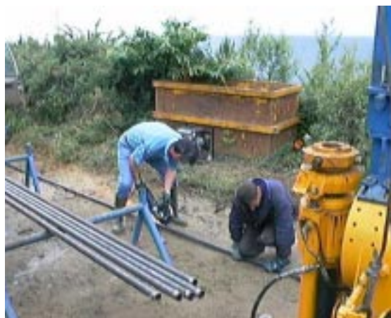
Fotografía 4. Entubación del sondeo JE-6R.
