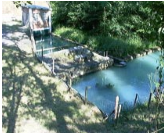
Fotografía 2. Cámara de carga y caseta de bombeo de la captación de los manantiales Goikoerrotta-2, afectados por la perforación del sondeo JE-7R (16/6/98)
