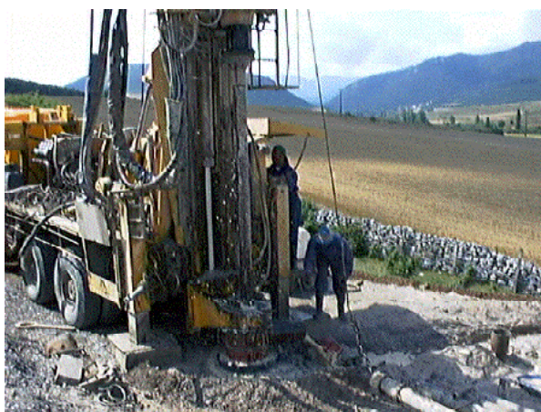
Sondeo OSMA-D: Perforando el metro 90.
