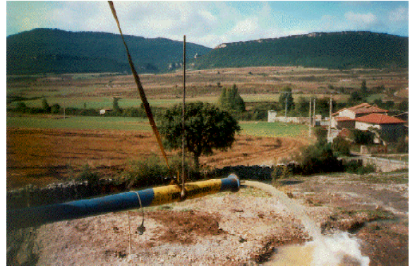
Bombeo Prolongado a 20 l/s en OSMA-D
