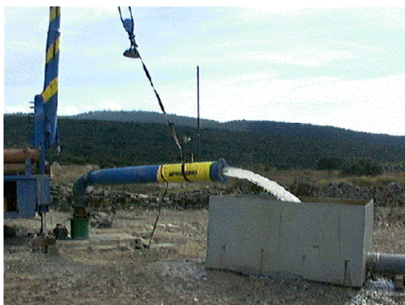
Contenedor habilitado para conducir el agua extraída hasta el río.
