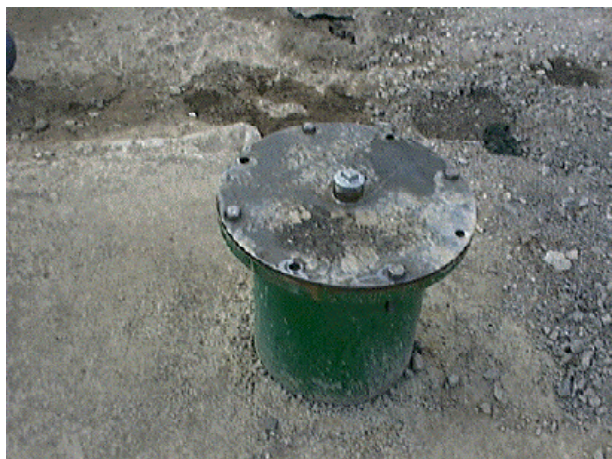
Acabado sondeo OSMA-C
