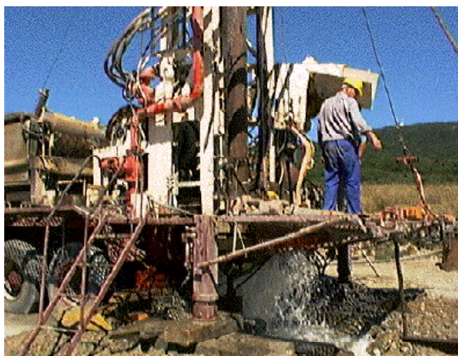
Sondeo OSMA-C: Perforando el metro 100.
