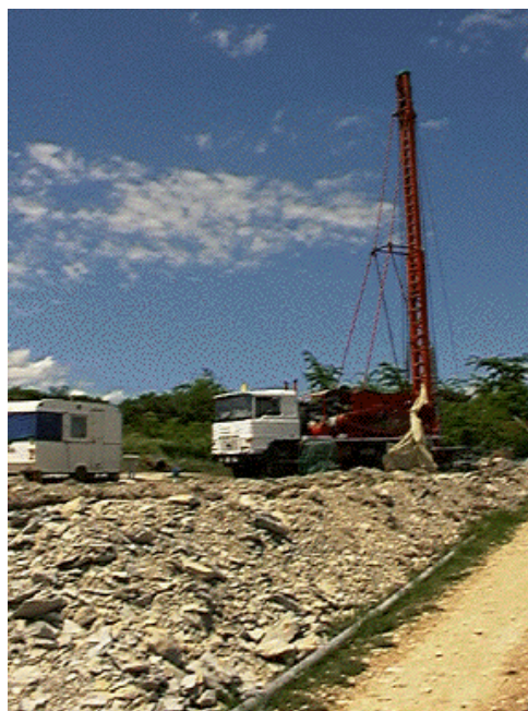
Emplazamiento sondeo OSMA-A
