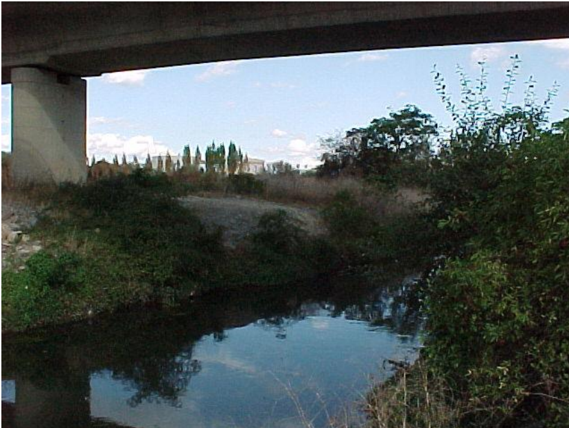
Vista del Zadorra aguas abajo de la depuradora de Crispijana. Vista del viaducto de la autovía.
