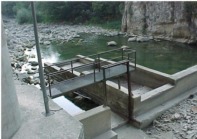
Detalle de la presa que existe antes de llegar a Subijana de Morillas
