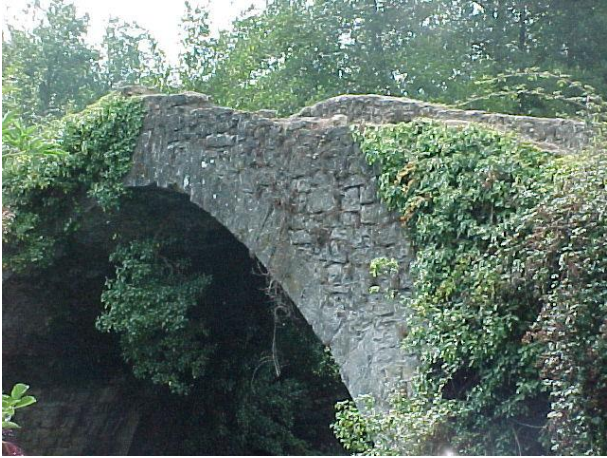
Vista de un puente (SBA01) localizado en este tramo
