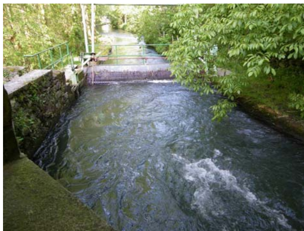
Foto 3. Área de acumulación y captura de esguines, al fondo la rejilla.
