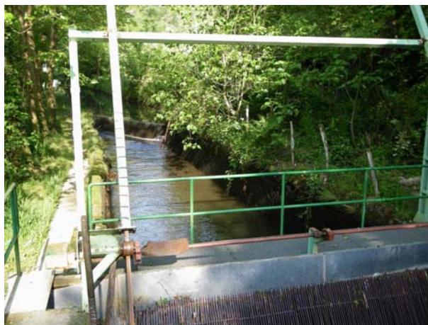
Foto 5. Canal en la zona posterior a la rejilla.
