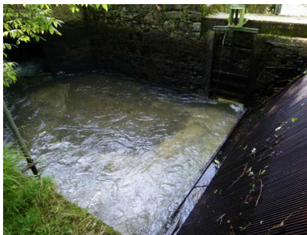
Foto 8. Vaciado a través de la compuerta de fondo o aliviadero
