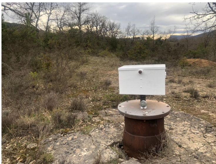
4. irudia SP02-Orbiso-2 zundaketa-kontrol piezometrikoko estazioa.
