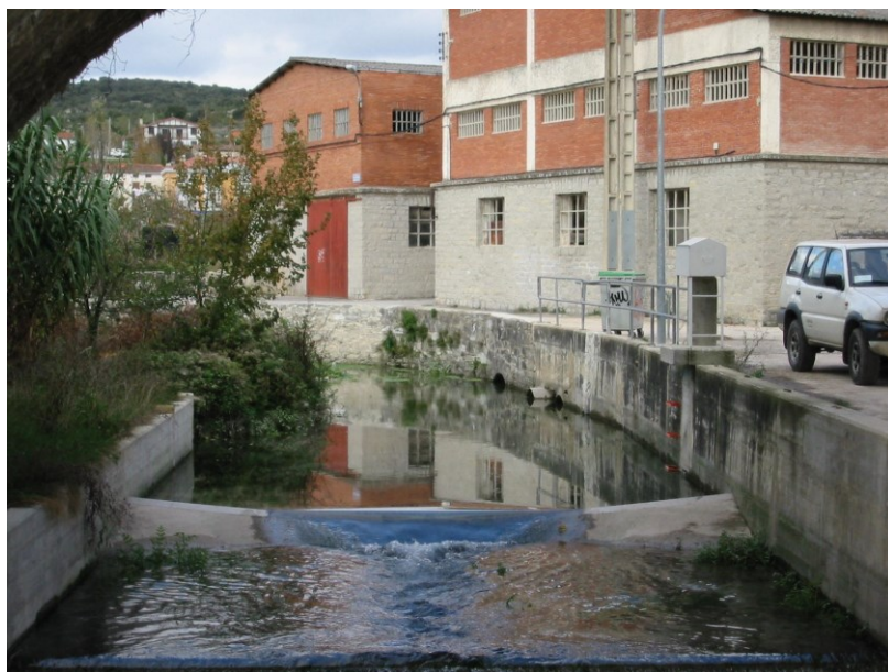
Figura 2 Estación de aforo SA04-Manantial Nanclares, con vertedero Crump, instalada aguas abajo del manantial.
