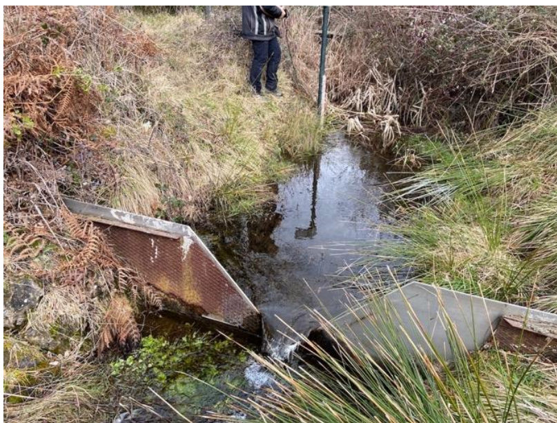
6. irudia Arreo Irteera emari-estazioaren itxura (Isurbide triangeluarra 90°).
