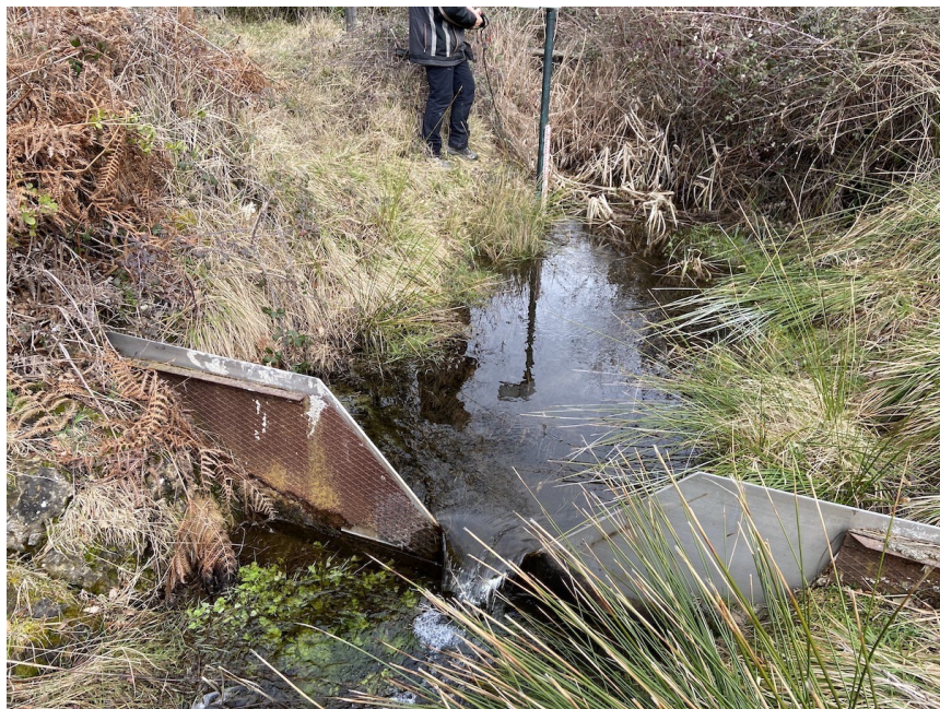
Figura 6 Aspecto de la estación de aforo Arreo Salida (Vertedero Triangular 90°).
