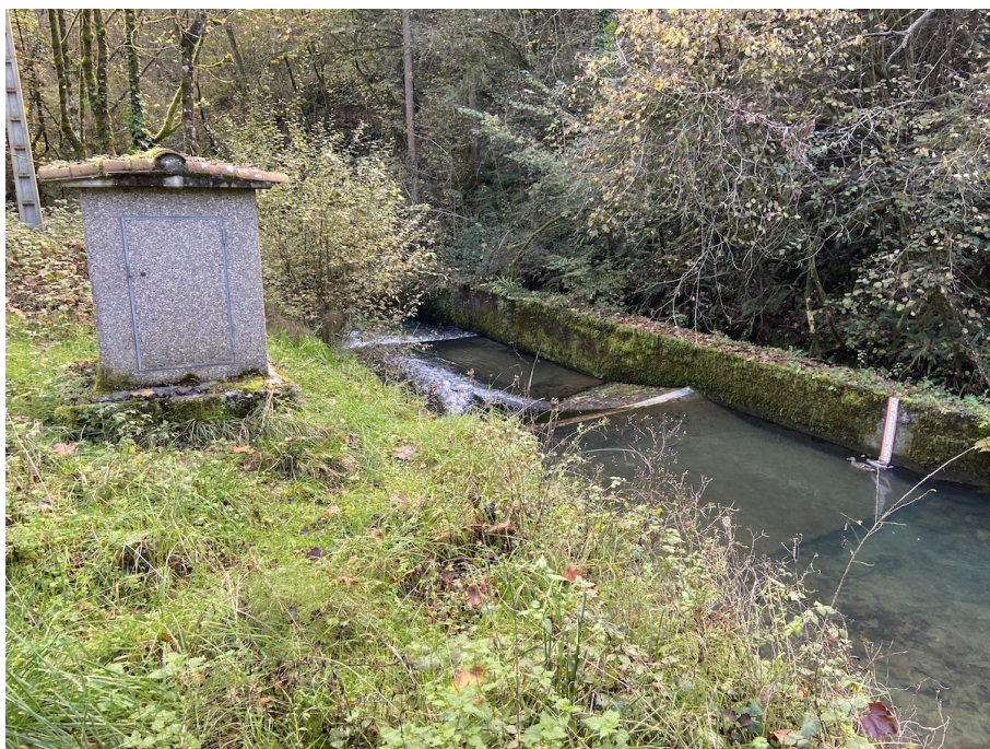
Figura 1 Estación de aforo SA10-Manantial Salubita, con vertedero Crump, instalada aguas abajo del manantial.
