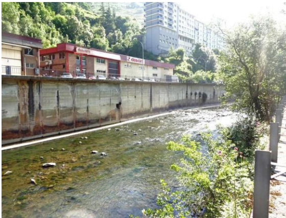
Figura 9 Canalización en el río Deba
