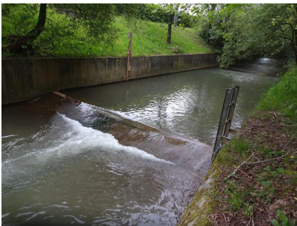
Figura 3 Estación de aforo de Elorrio
