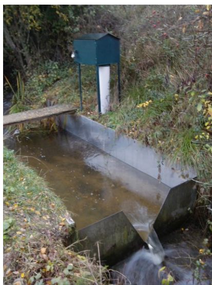
Figura 9 Aspecto de la estación de aforo Arreo Entrada (Vertedero Triangular 60°).
