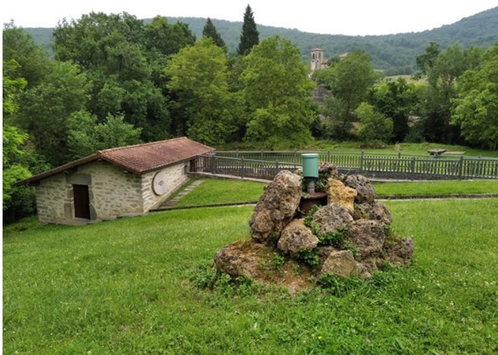
Figura 2 Estación de control piezométrico SP23-Sondeo Lendoño.
