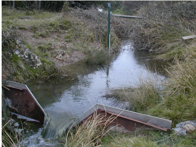
Figura 8 Aspecto de la estación de aforo Arreo Salida (Vertedero Triangular 90°).
