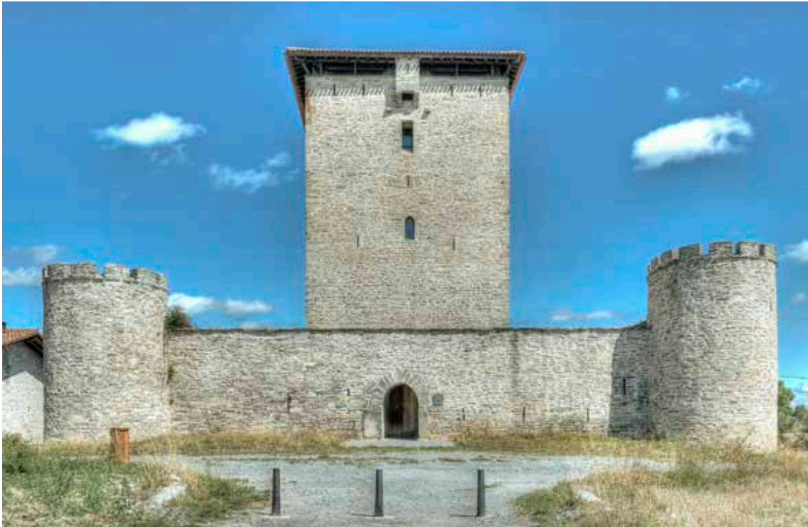
Vista frontal del Castillo de Mendoza, con recinto amurallado de forma rectangular, midiendo en altura unos cinco metros y fortificado con cuatro torreones.
