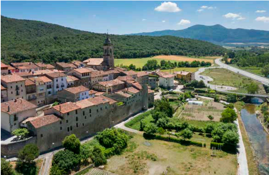
En la imagen superior, vista aérea de la localidad de Antoñana.
