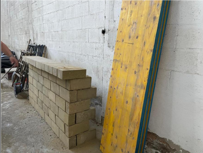
Prueba de proceso constructivo con BTEC en seco (sin mortero).
