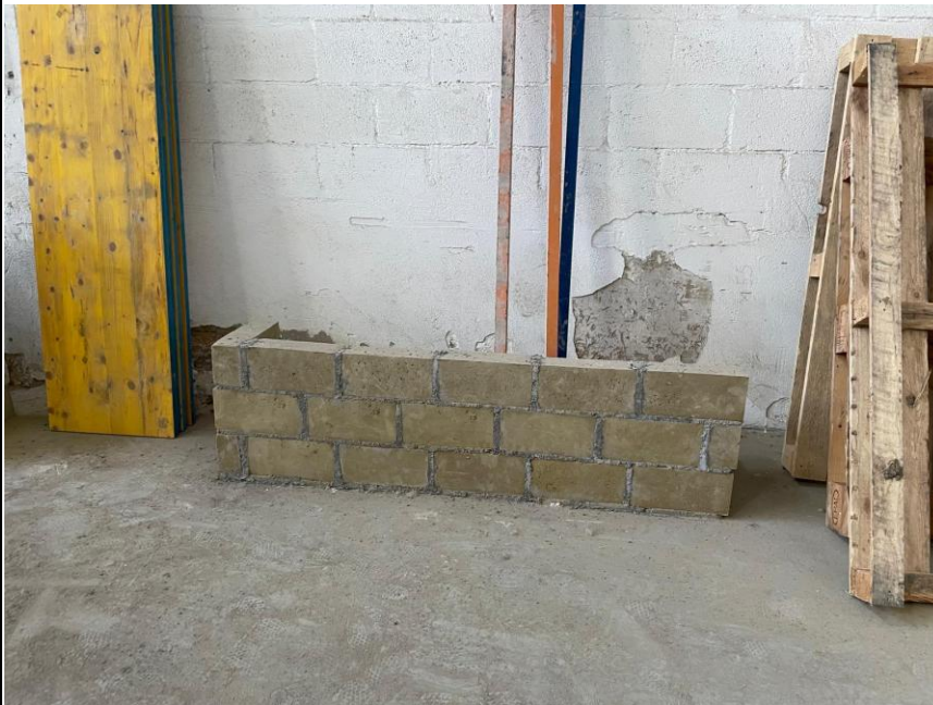
Prueba de proceso constructivo con BTEC y utilizando mortero.
