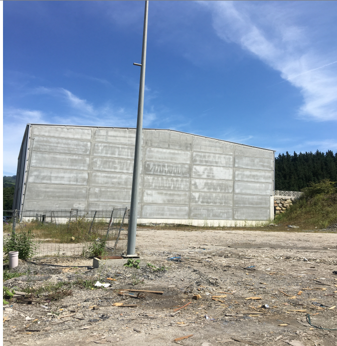
Fotografía 1: Situación actual. La dirección de la obtención de la imagen es la indicada en la fotografía aérea del emplazamiento. En esta fotografía se observa la situación actual de la campa objeto a estudio y el pabellón anexo a la misma.
