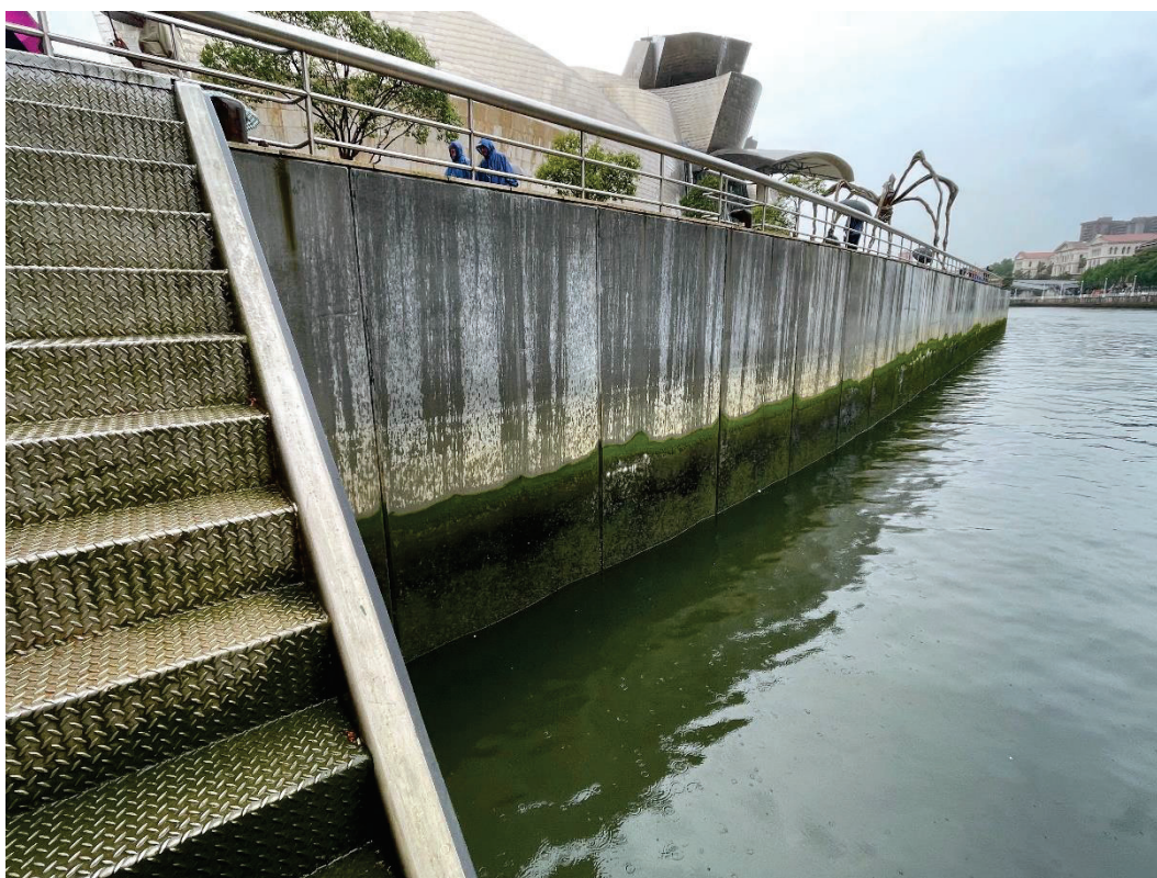
Faldones reparados en muelle de la Zona 1B.
