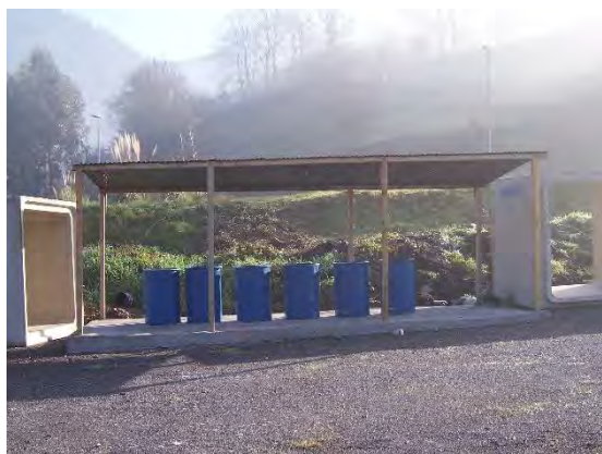
Punto limpio en construcción
