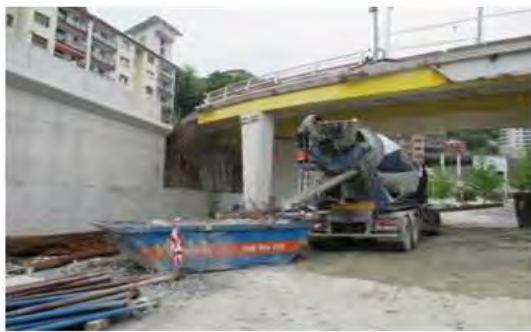
Imagen.4. Detalle punto de limpieza de las canaletas de las hormigoneras.
