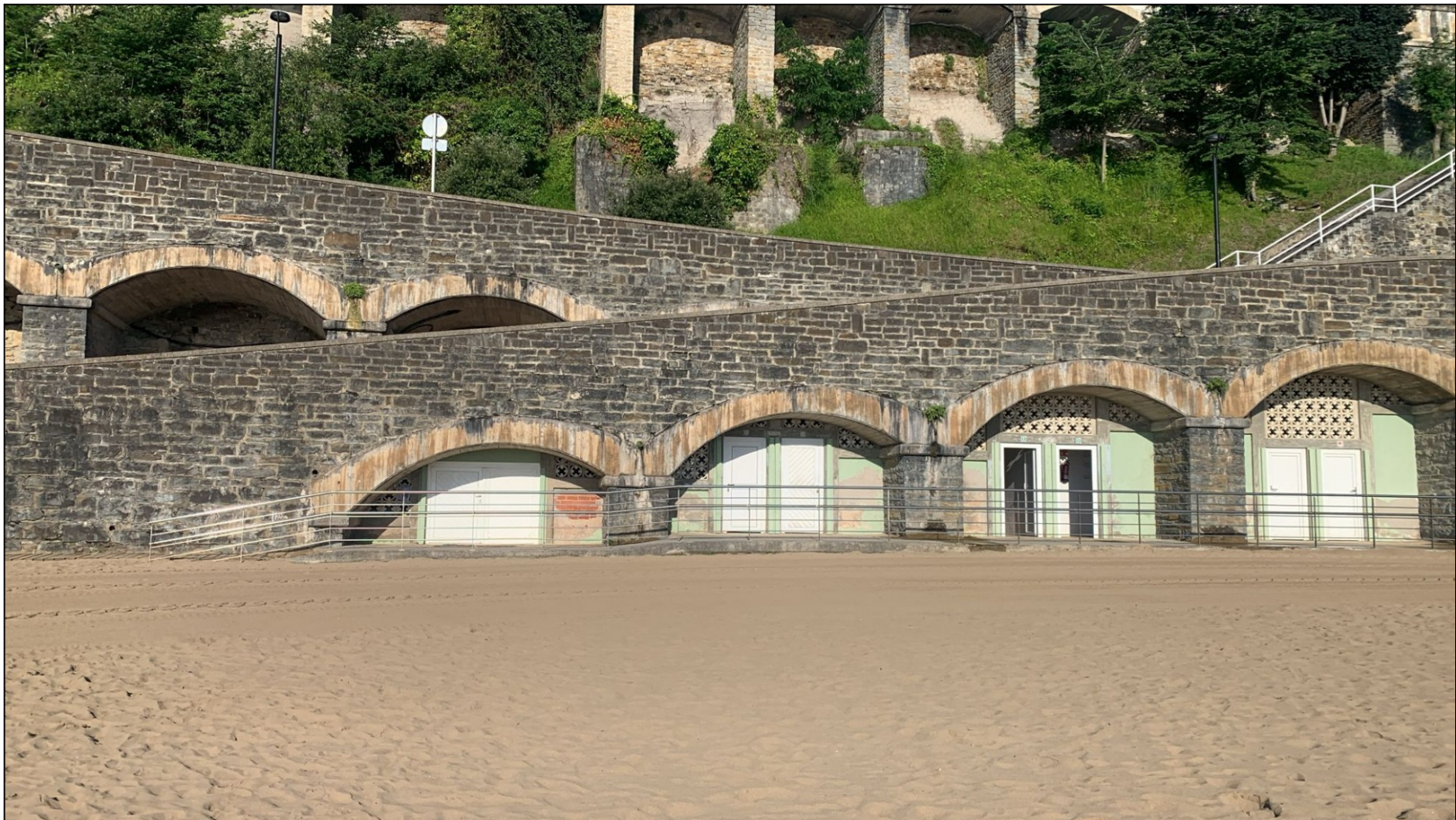
ALMACEN BAJO LA RAMPA DE ACCESO A LA PLAYA 47.00 m2
