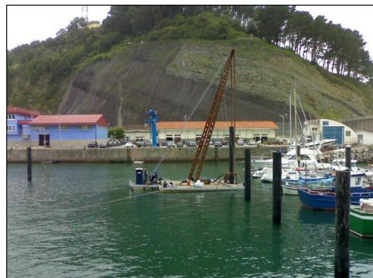
En la parte delantera del módulo central se le instala una estructura de acero que sirve para la sujeción y posterior guiado de los pilotes.
