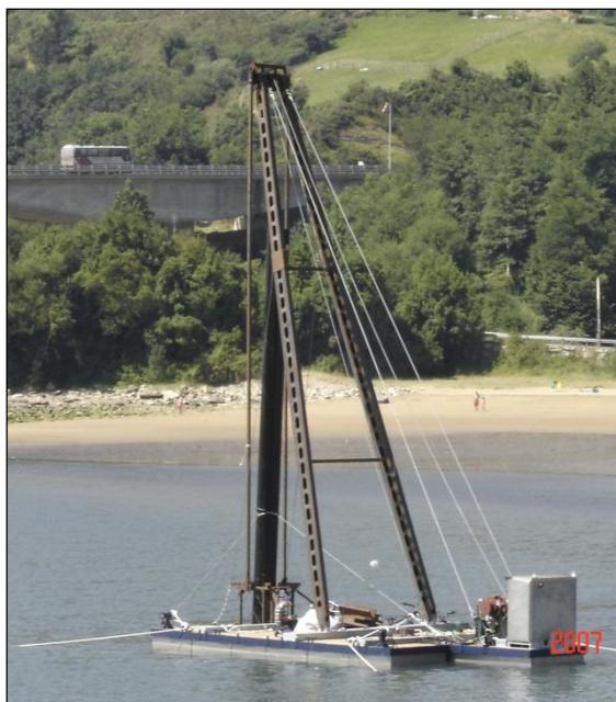
Una vez posicionada la maquina en la zona de trabajos se procede a desplazar el pilotes desde la zona de acopio hasta la zona de trabajos. Para ello se tapan las cabezas de los pilotes para que queden estancos y asi floten.
