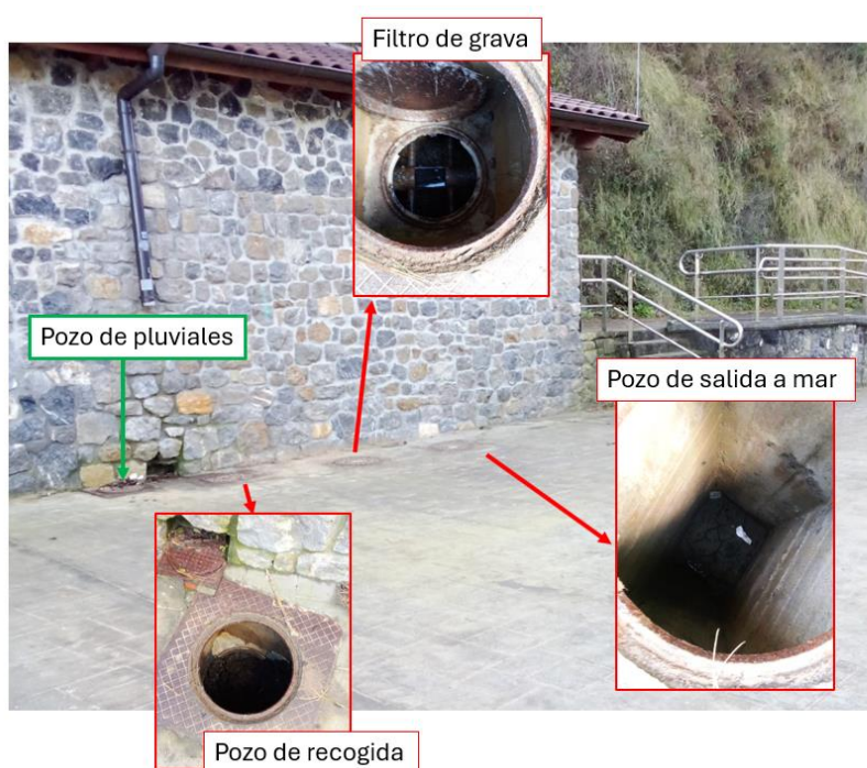
Esquema del vertido al mar de los baños públicos del muelle
