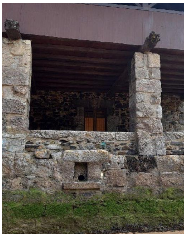
Punto de vertido del edificio Beletxe
