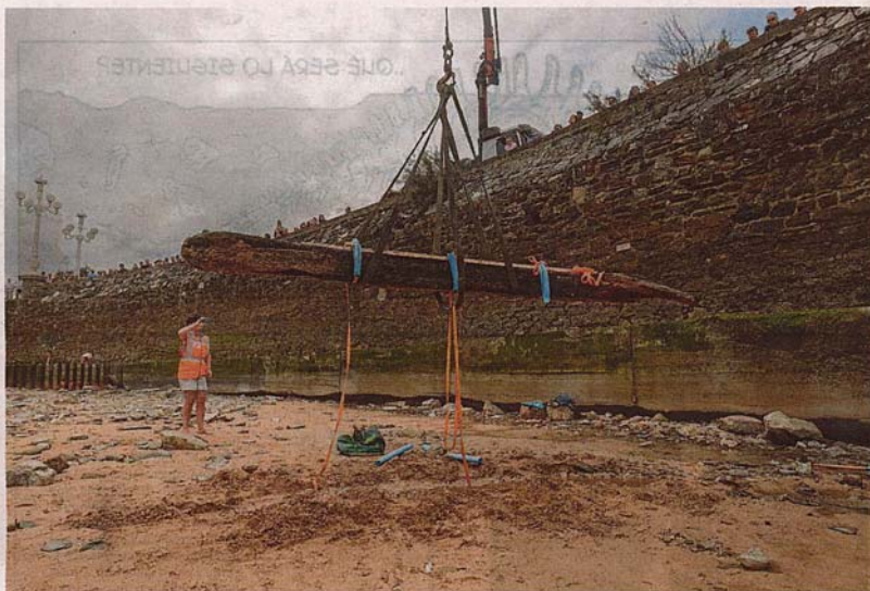
La cuaderna es izada por un camión-grúa ubicado en el paseo Eduardo Chillida que la transportó a Gordailua. usoz
