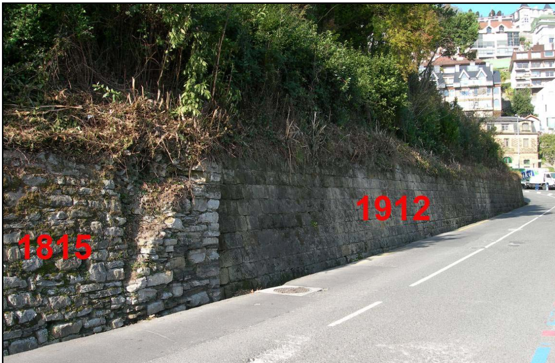
Figura 30. Muro de mampostería caliza (1815) y muro de bloques “sillares” de piedra de arenisca (1912).
