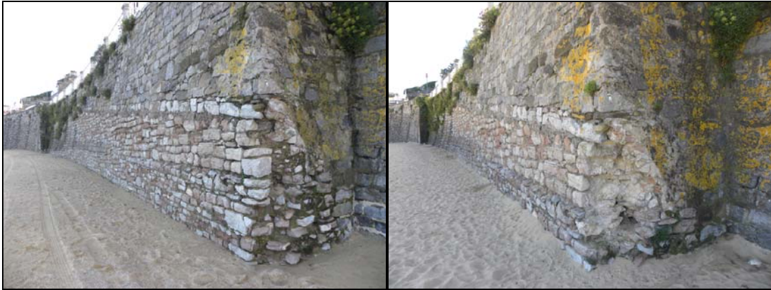
Figuras 63-64. Referencias de variación del nivel de arena en el muro de costa (Fecha: 02-11-2012 y 10-10-2016)
