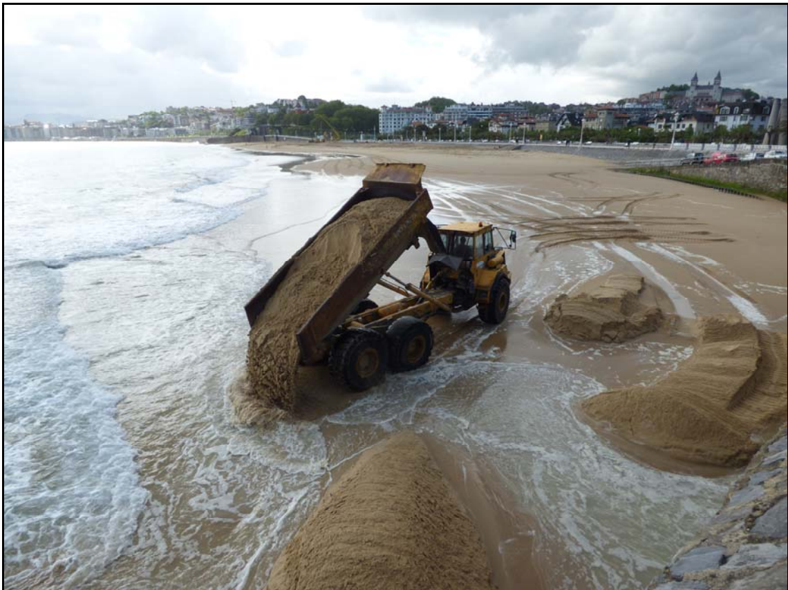
Figura 66, 67. Traslado de arena de la zona alta oriental y depósito en la orilla occidental el 21-05-2015.
