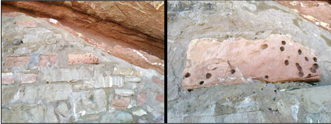
Figura 23 a, b. Detalle de muro de costa en Loretopea, caliza roja afectada con lithófagas.
