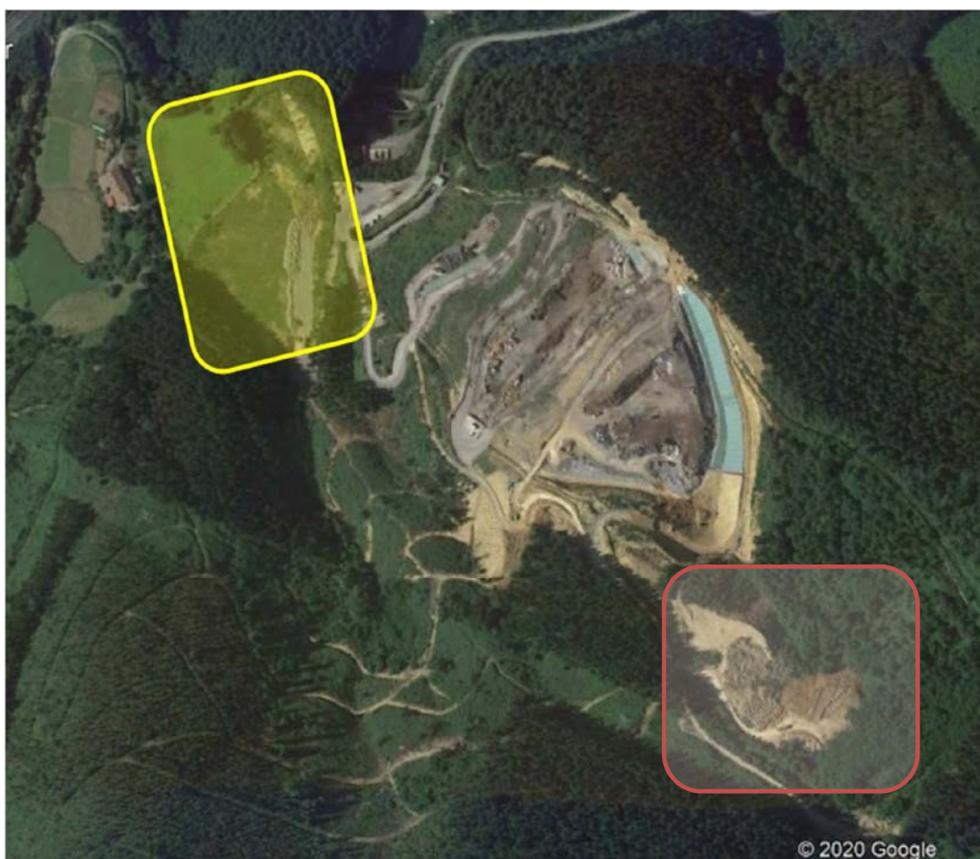
Figura 1. Emplazamiento depósito 1 (en amarillo) y depósito 2 (en rojo)
