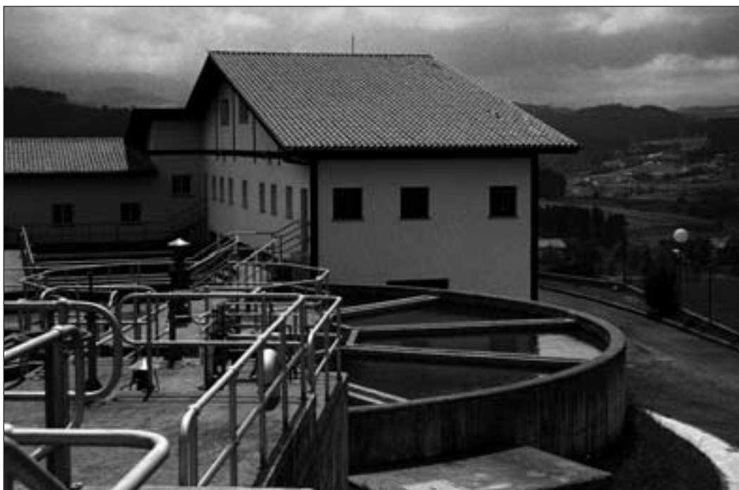
Ajangizko ur-tratamendurako instalazioak
