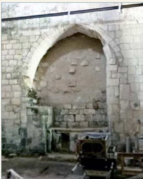
Fig. 74. Acceso reaprovechado como capilla.
