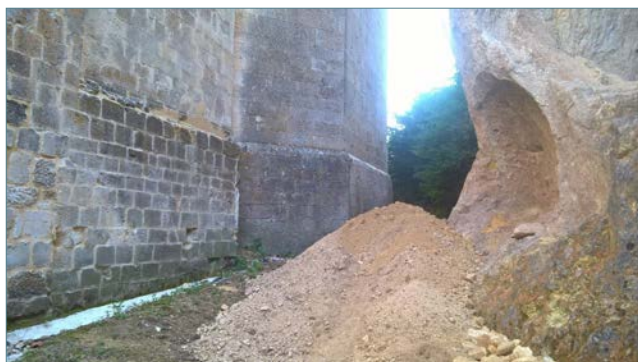
Fig.48. Los retranqueos de la iglesia se corresponden en altura con los mechinales de las cuevas
