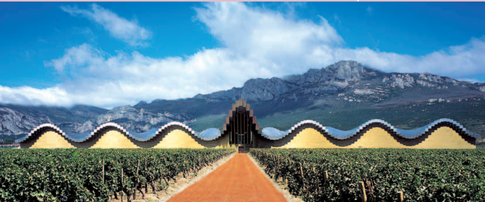
La concepción escultórica de la bodega Ysios, obra de Santiago Calatrava, se integra armónicamente en el paisaje rodeado por la Sierra de Cantabria.
