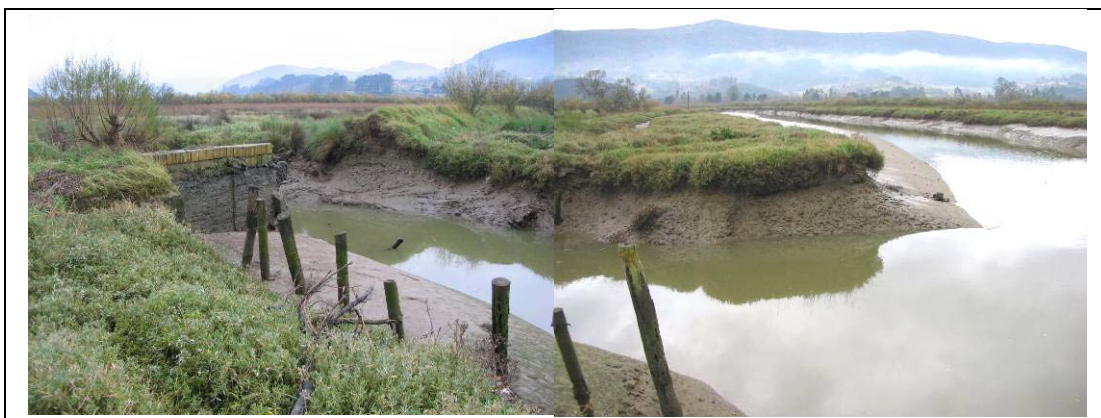
Estado de la compuerta central al lado de la ría. Se observa la sección de la muna.
