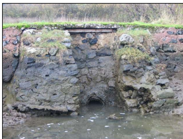
Ampliación vista interna
