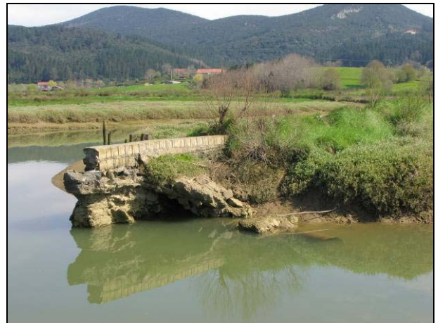
Ampliación vista interna
