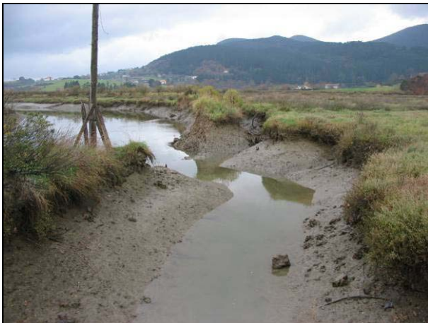
Principal punto de rotura de la muna de Baraizpe en el lado de la curva de la ría.
