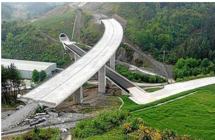
Imagen 1. Obras de la nueva autovía de Descarga
