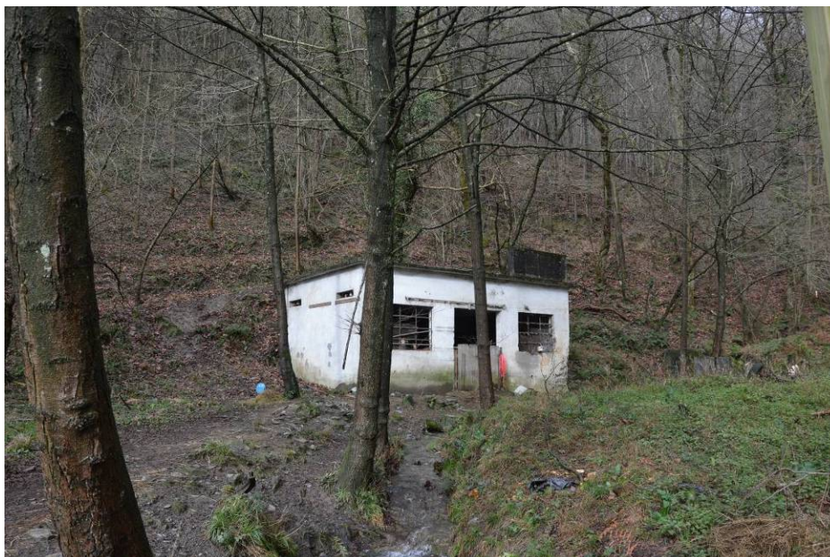
Edificio de compresores
