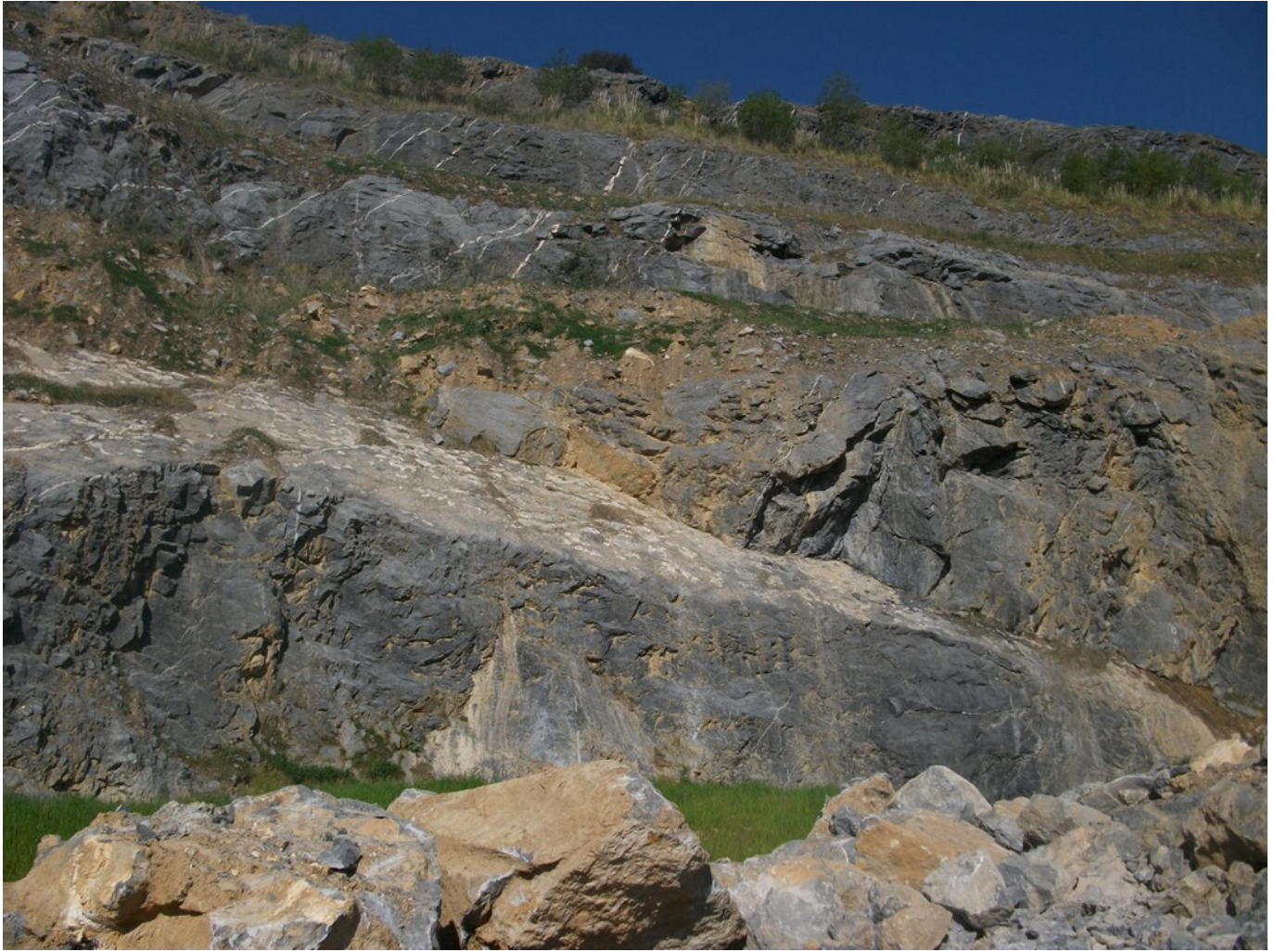
Figura 12. Rotura Planar a favor de J_1 observada en los bancos actuales de 2C.
