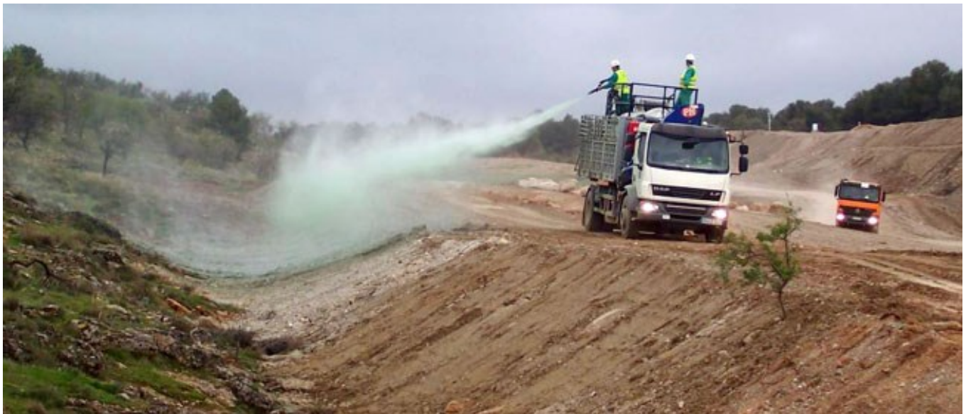
Figura 16. Camión en labores de hidrosiembra
