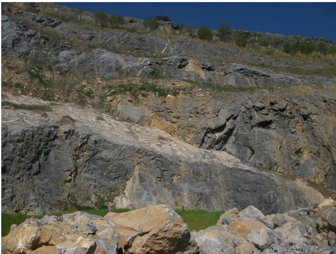
Figura 7. Primer plano de las roturas planares (lisos)
