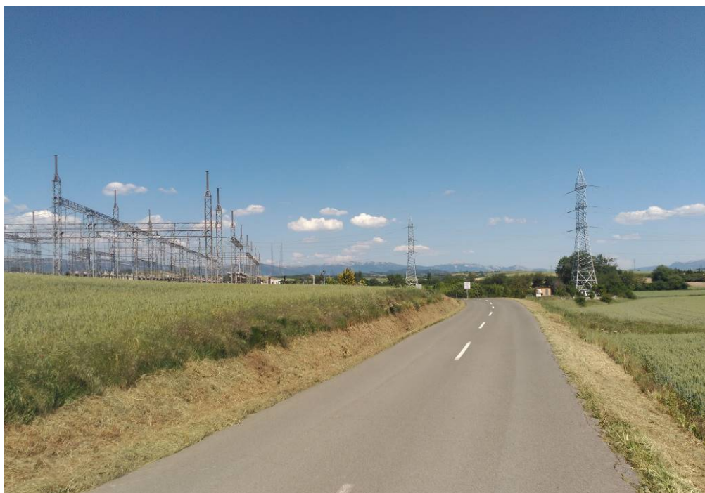
Fotografía 3. Zona de la Subestación de Vitoria donde comenzará la línea.
