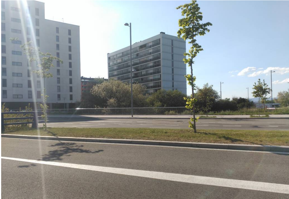
Fotografía 30. Paso del río San Tomas bajo la calle La Ilíada.
