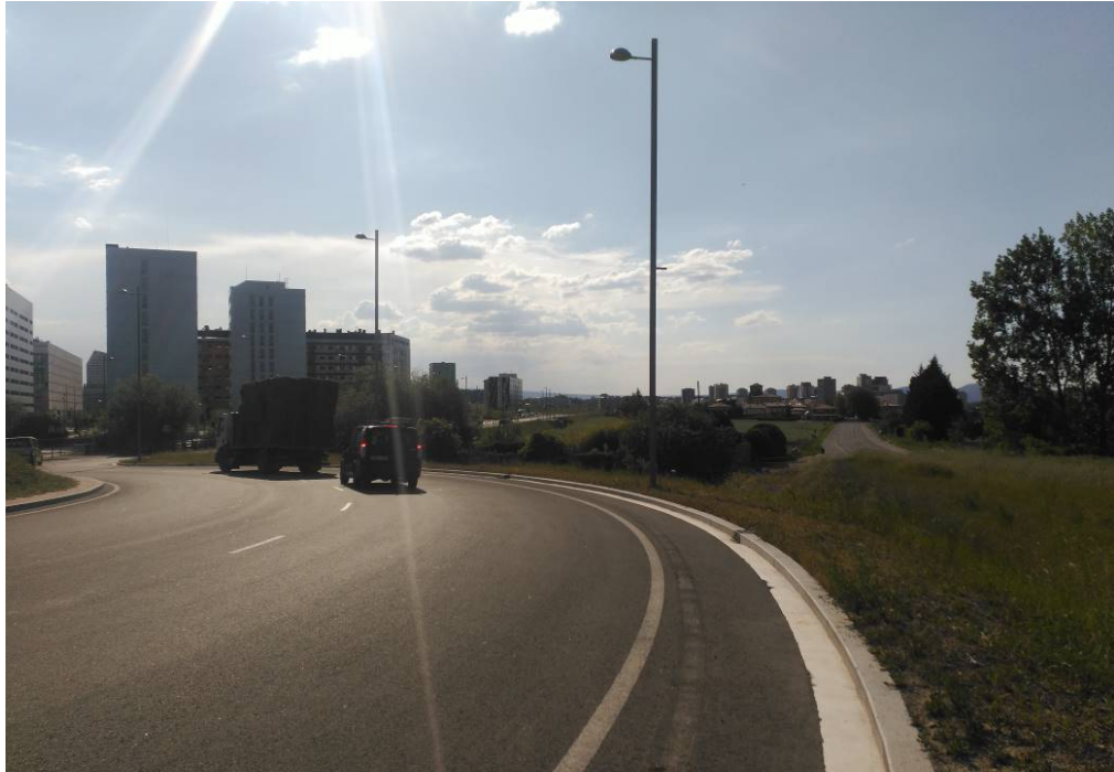
Fotografía 31. Rotonda en el final de la Avenida de Bruselas.
