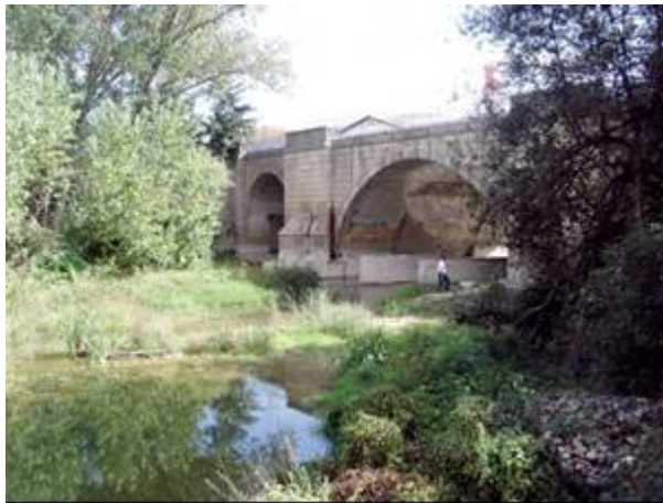
Figura 7 Zona B-3 (puente sobre N-I)
