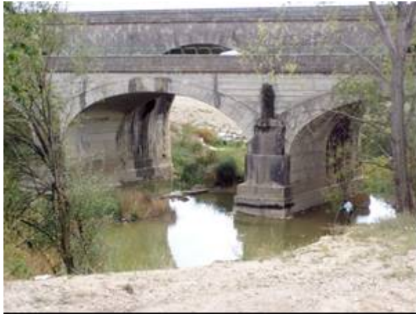
Figura 8 Zona B-4 (Puente ferrocarril)
