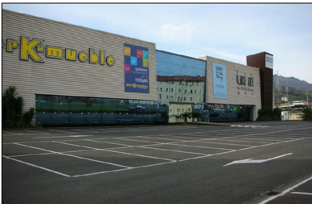
Edificio ubicado en el ámbito de la modificación. Fotografía: Arrutiark
