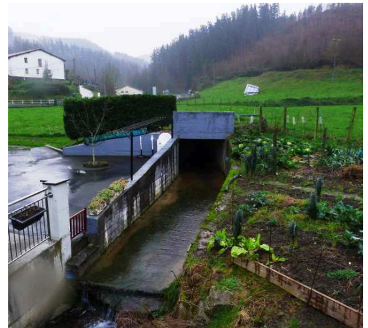
Final de la cobertura del arroyo Saratsibar
