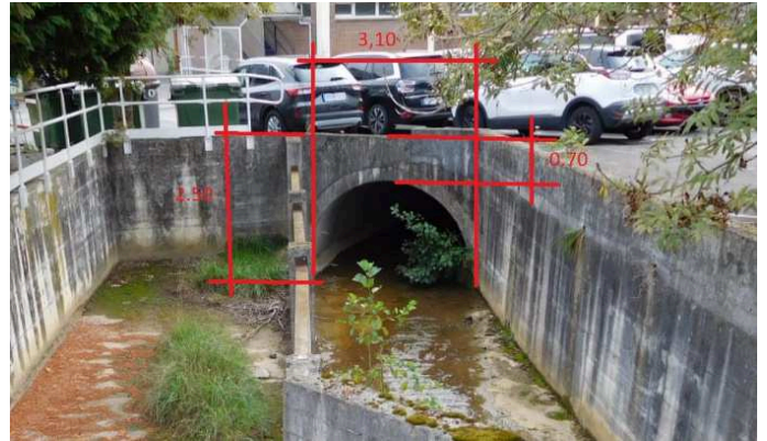
Cobertura del Ugaitz, hacia aguas abajo, al fondo las instalaciones de OIaso.
