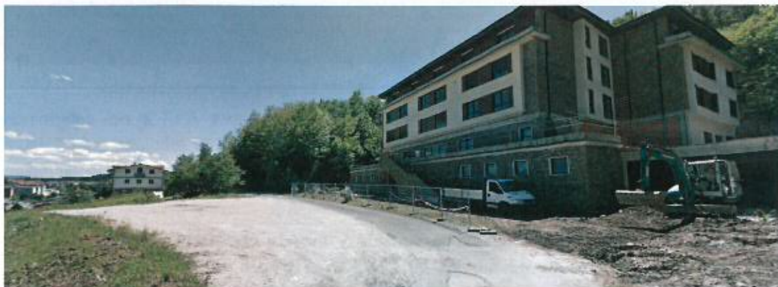
Imagen 1. A.I.E.7 Pagoeta Hotela, frente del edificio del hotel sin terminar y de la explanada para aparcamientos (fuente: Google Street view).
