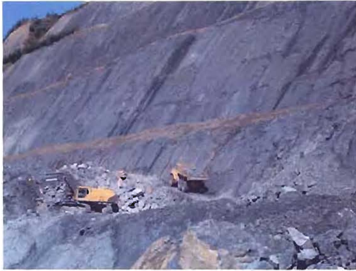
Foto 5. Relleno de inertes de los bancos BE-05 y BE-06.
