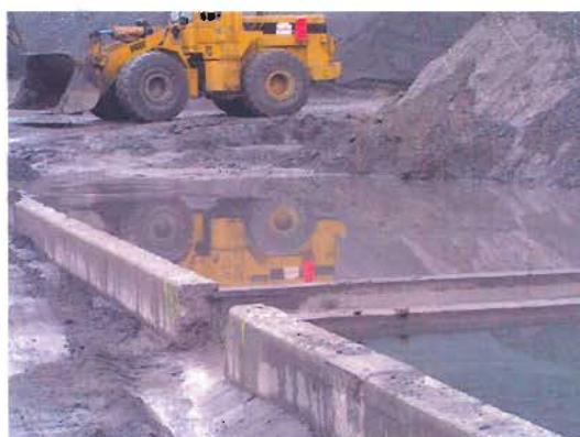
Obra de separación de las escorrentías a la salida del túnel finalizada
