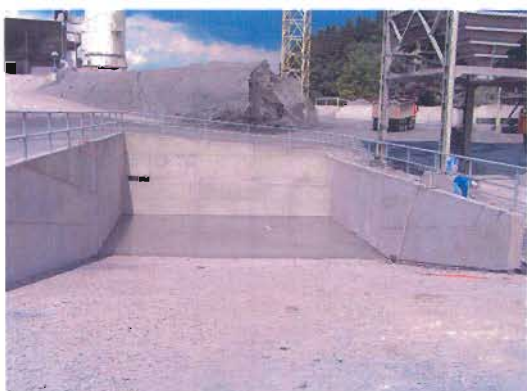
Imagen de la reforma de la balsa de silos, punto final del vertido 1
