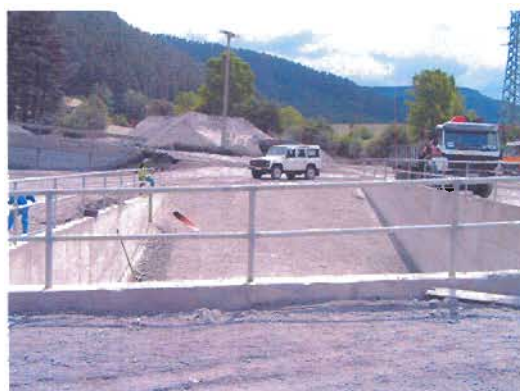
Imagen en detalle de la balsa reformada
