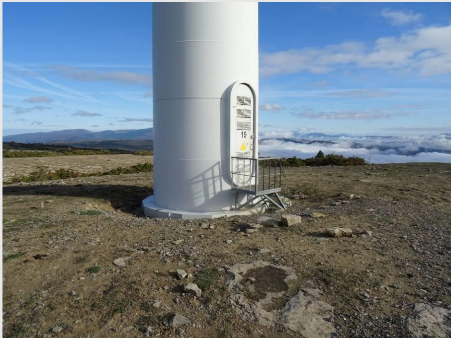
Fotografía 6. Detalle de la base del aerogenerador A19 del parque eólico.
