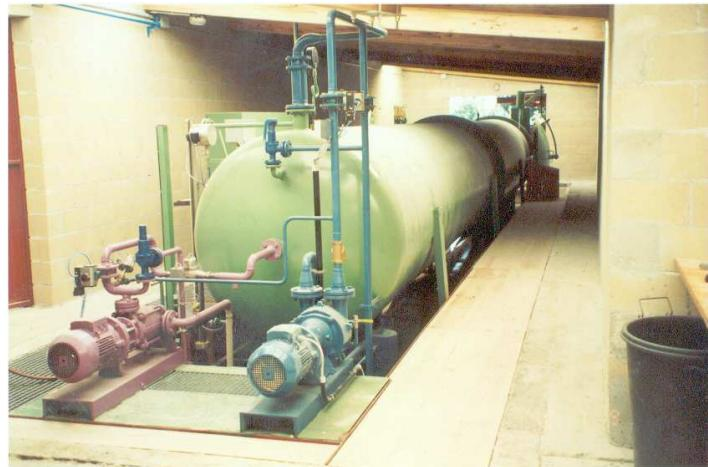
Los elementos metálicos son galvanizados, tanto los componentes principales como la tornillería de unión y han sido diseñados para trabajar en condiciones óptimas sin necesidad de mantenimiento durante 25 años.
