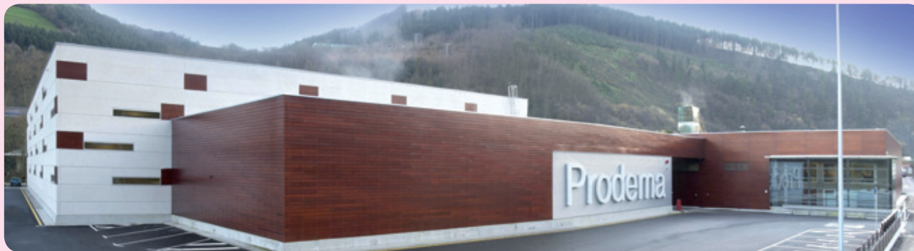
◀ Instalaciones de Prodema, S.A. en Legorreta (Guipúzcoa). Fuente: Prodema S.A.
