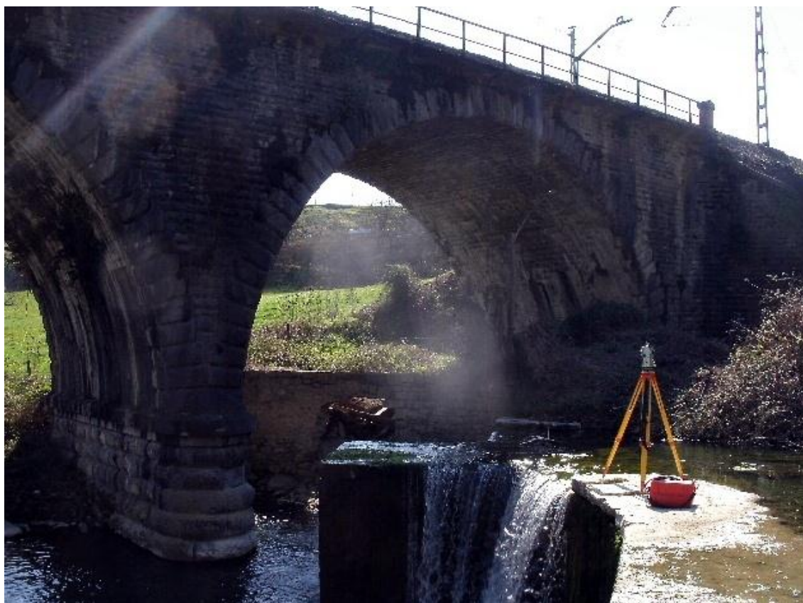
Figura 31. Ejemplo de medición de una estructura nueva con estación total
